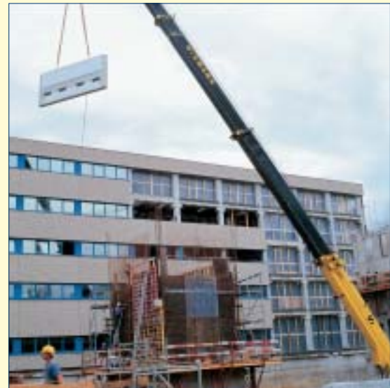
Mobile Fassadenplatten, Neubau VA
